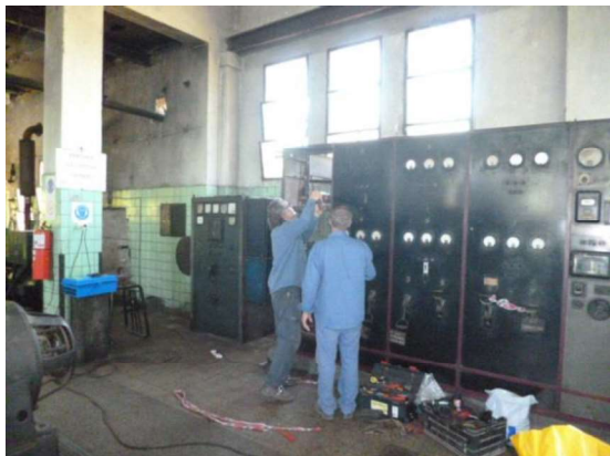
Imagen Nº 1 – Instalación del Multimetro SATEC en la Usina.
