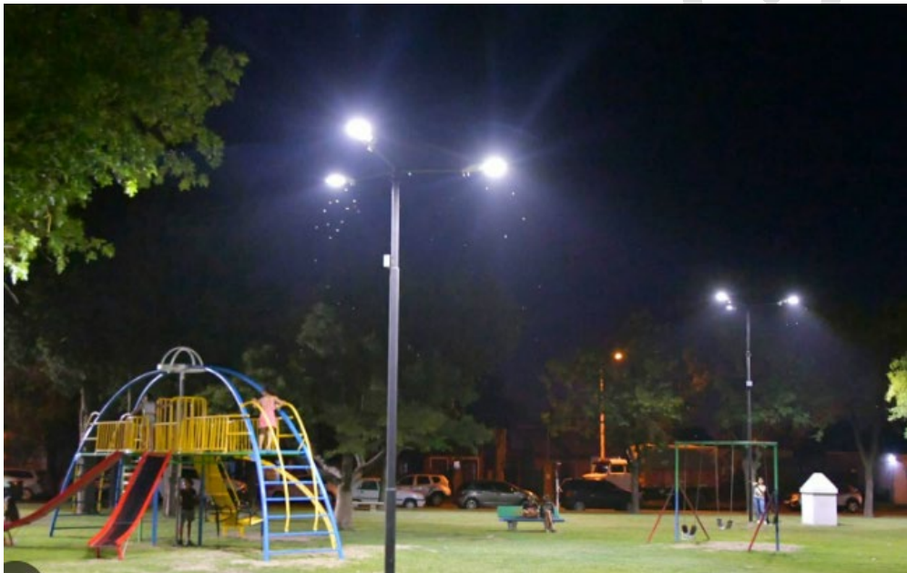
Ejemplo sistema de Iluminación a Proveer
